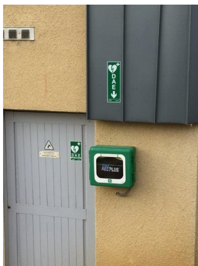
La MTL au sous sol
