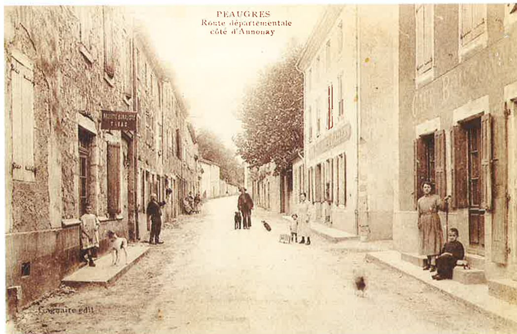
La nouvelle route de Peaugres date de 1839 ... A droite, la maison au premier plan a été démolie en 1989 pour faciliter l'accès au centre commercial.
