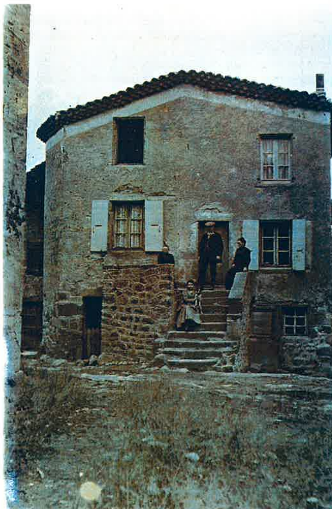
Cette photo daterait environ de 1905. Bien difficile n'est-ce pas d'y reconnaître le cabinet médical de Peaugres. La façade principale donnait alors sur l'école Les Tamaris derrière l'église. La propriétaire était Marie-Euphrosine MAGNARD dite "Rosine" en haut à gauche, à droite sa soeur Jeanne-Marie et au centre le mari de celle-ci Antoine CHOMEL. La quatrième personne est inconnue.
