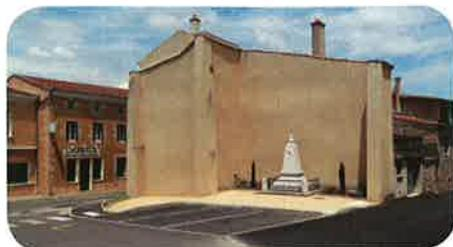
en enrobé sur le parking et la voirie constitue la couche de finition, un gravier de Poliéna jaune apporte une touche de couleur sur les cheminements piétons. En souterrain, un réseau d'arrosage et des fourreaux électriques
