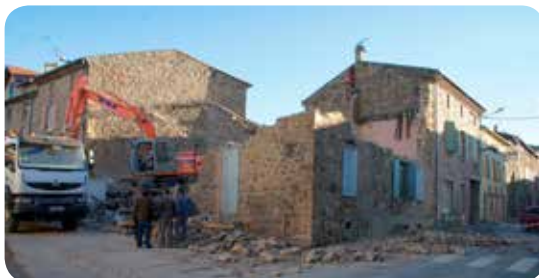
Démolition maison Linossier
