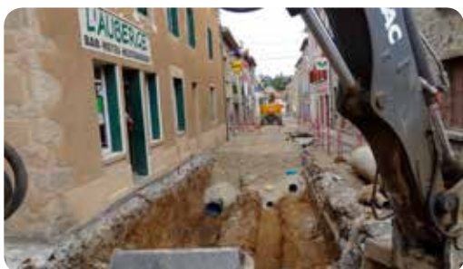
Travaux rue centrale
