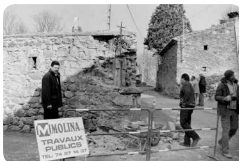
Démolition maison Reymond
