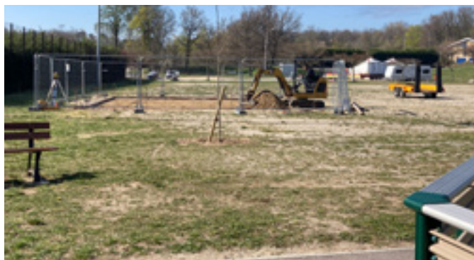
Préparation de la surface
